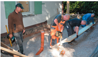
Bei der SSG Queidersbach tut sich was: Die Küche muss erweitert werden. Hier sieht Vorsitzender Marc Leis (links) unserem Landessportleiter Helmut Hörig (Mitte) beim Arbeitseinsatz zu.
