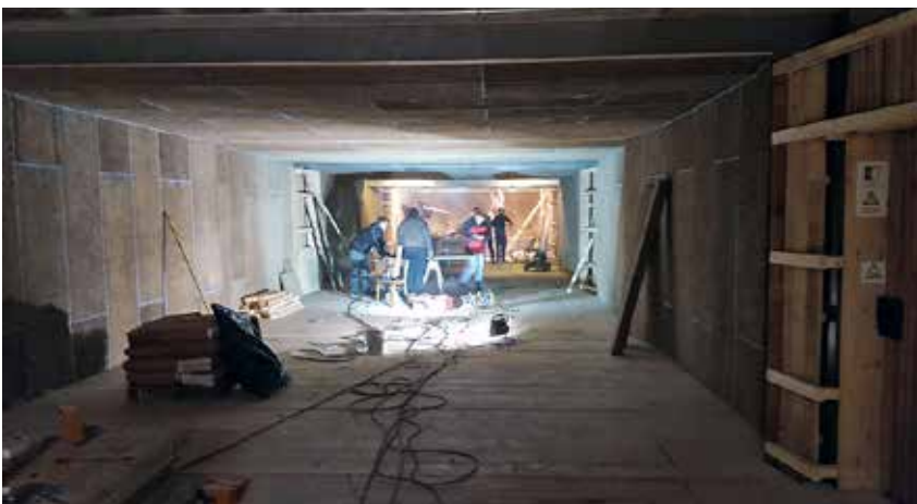
Der Stand während der Umbauarbeiten.
